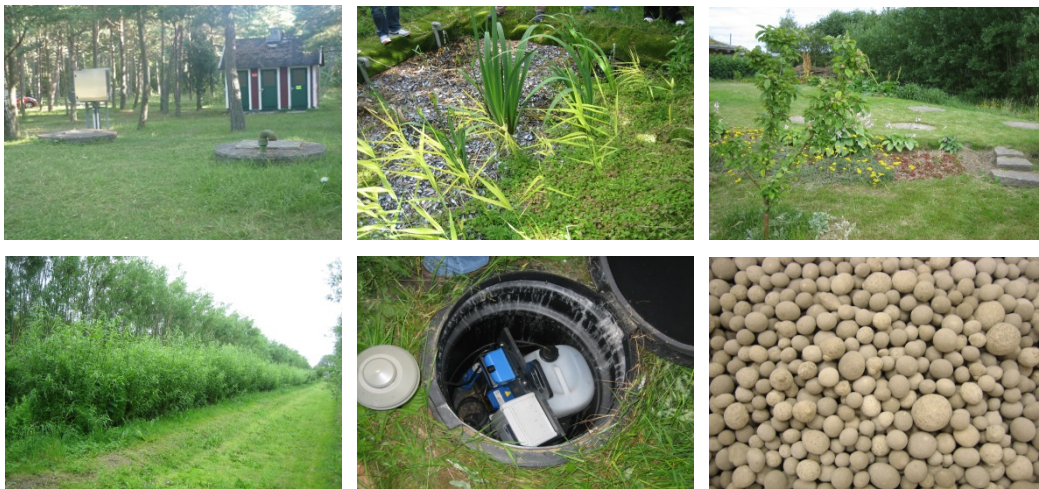
Figur 1 Småskalig avloppsrening: på en camping på Gotland (vänster övre), pilsystem med noll-utsläpp i Vittrup/Danmark (vänster nedre), biologisk rening i musselskal-bädd med vertikalt flöde (mitten övre), brunn med doseringsenhet för fällningskemikalie (mitten nedre), reaktivt filter för fosforrening (höger övre) och reaktivt filtermaterial (höger, nedre)
