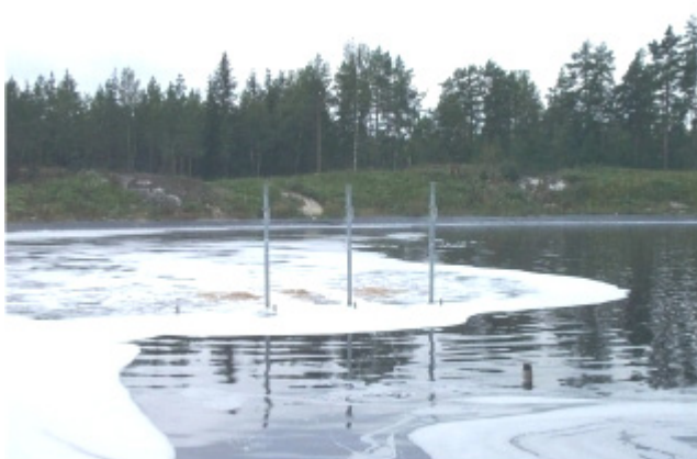
Figur 1 Luftningsbassängen för lakvatten i Högbytorp.
