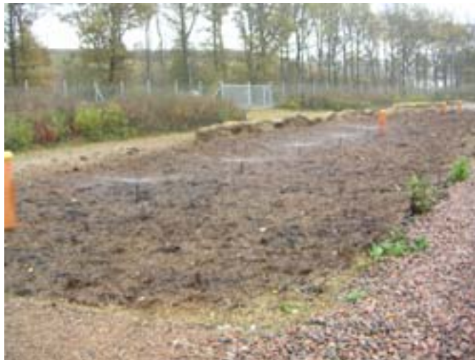
Figur 8 Biologiskt filter där vatten sprids ut
