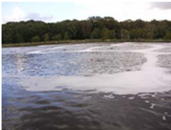
Figur 1 Luftad damm med ytluftare
