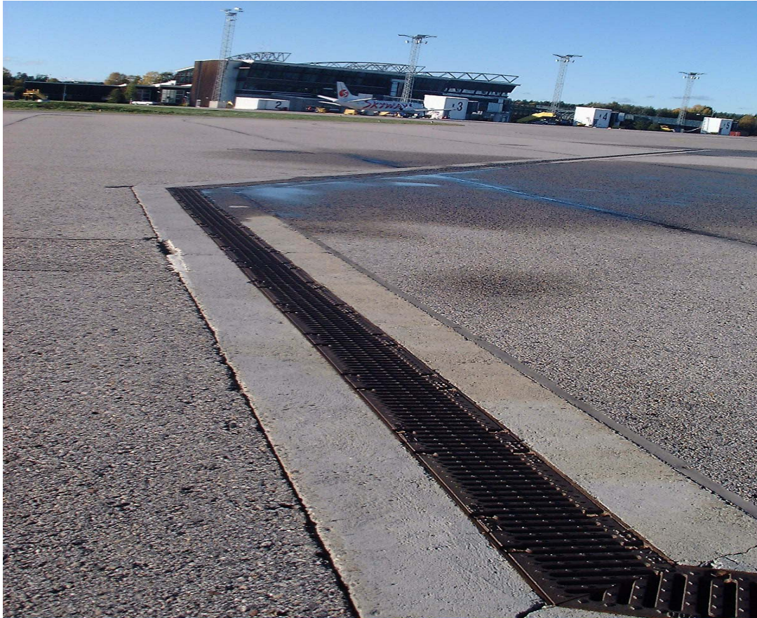
Figur 2: Ytliga ledningar för uppsamling av använd avisningsvätska. Fotot är tagen på Sundsvall-Härnösands flygplats stationära avisningsplats år 2003. (Foto: L.Marklund)
