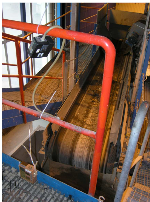
Figur 4.2: Provtagning av damm och VOC i containerrummet
