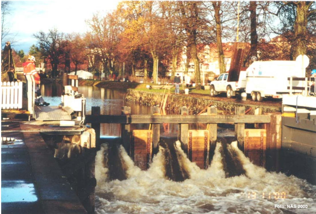
Figur 5 - 2 Balksektionen uppströms övre slussporten i Säffle sluss den 13:e november 2000. Arbetet med att öppna slussen har påbörjats och tre av de 21 luckorna har tagits bort.
