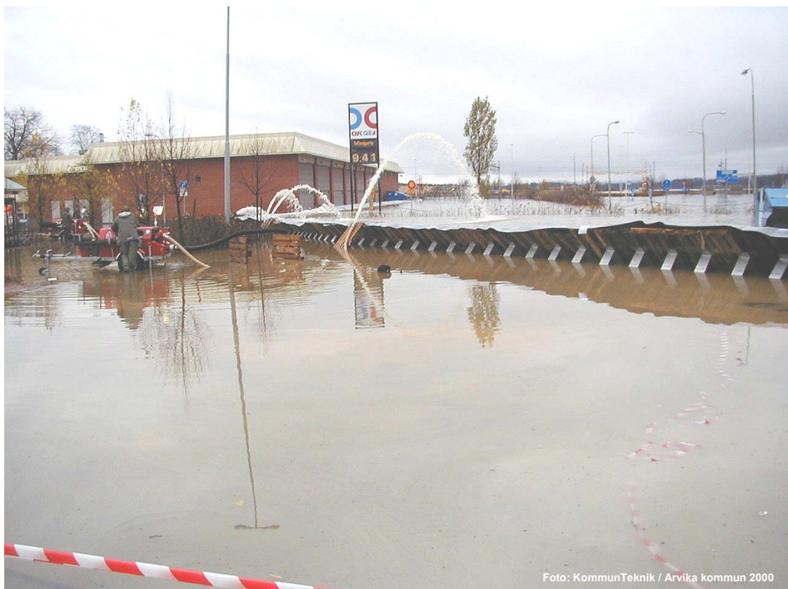
Figur 1 - 2 Temporära invallningsanordningar byggdes upp för att hålla nere vattennivåerna i vissa områden i Arvika. Pumpar pumpade vatten för att kompensera för läckage genom vallar och mark.
