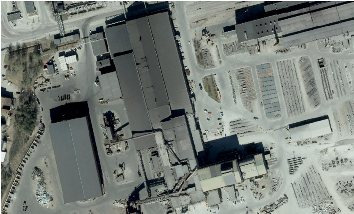
Figur 7: Byggnad och takyta för Stålverk 64. Tillåten återpublicering. Copyright © Esri 2021-03-22
