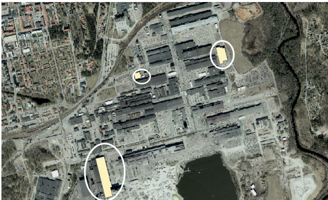
Figur 5: Ortofoto över Sandvik AB:s industriområde i Sandviken. Längst till vänster motsvarar den inringade byggnaden Stålverk 64, i mitten motsvaras den av Pressverk 69 och till höger av Betning 2016. Tillåten återpublicering. Copyright © Esri 2021-03-22.
