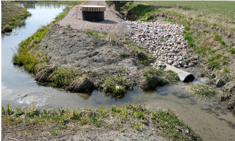
Figur 7 Dike i Gottsunda dagvattenpark med skarp krök med möjlighet till bräddning till befintligt dike rakt fram.
