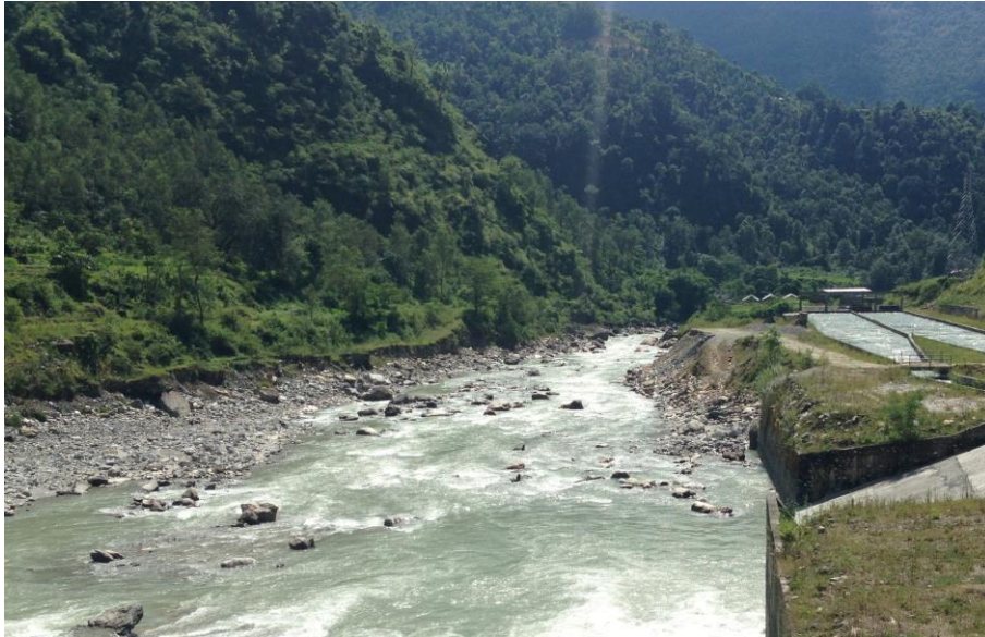
Figur 13. En torrfåra nedströms en damm. Foto: Simon Ene
