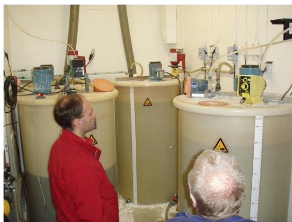
Figur 4. Till höger, två doseringstankar för soda. Till vänster doseringstank för polyaluminiumklorid.
