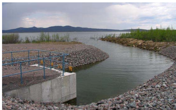
Figur 9. Nybyggt utskov i fast mark i Kiruna. (Foto: H. Lundström)
