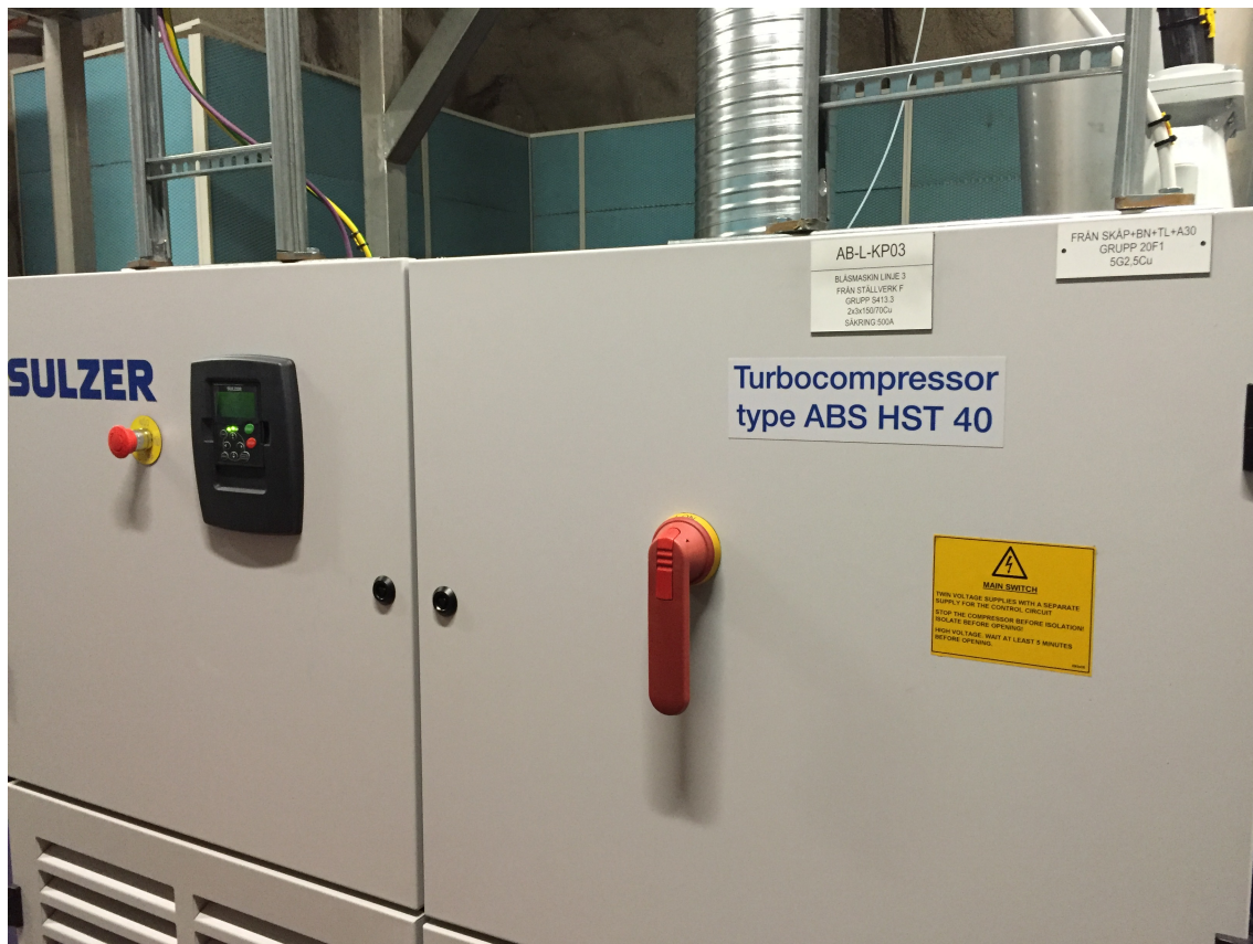
Figur 2.3. Blåsmaskin av typ HST40 på Bromma reningsverk. Foto: Erik Lindblom, 2017.
