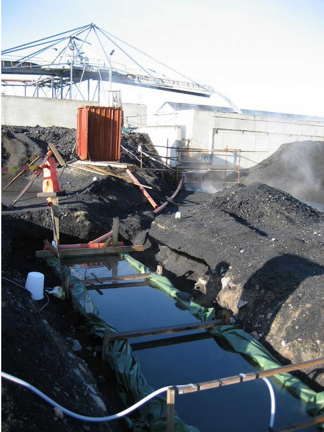
Sedimenteringsbassängen igen. Avvattningsbassäng och efterföljande sedimenteringsbassäng syns i bakgrunden (har vita väggar). Notera avloppsroret som leder vatten från utloppet av stora bassängen till pilotförsöksbassängen.
