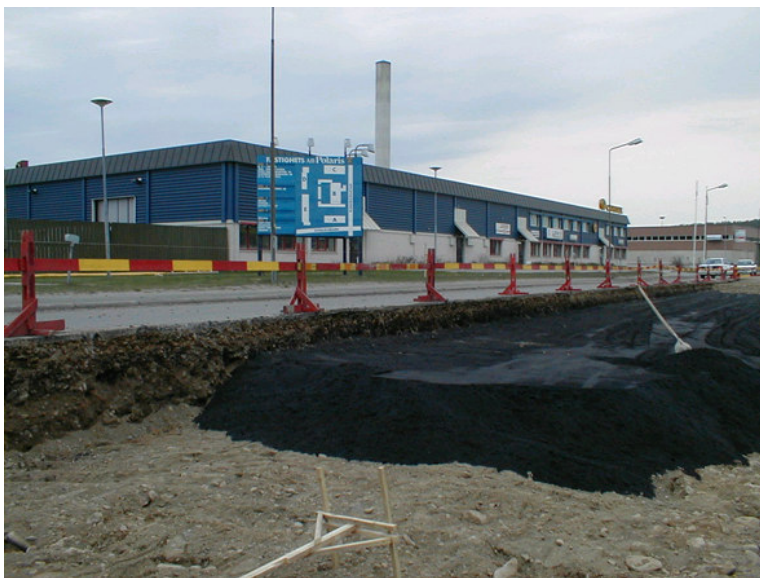
Figur 2.3 Exempel på järnsandsanvändning vid vägbyggnad.
