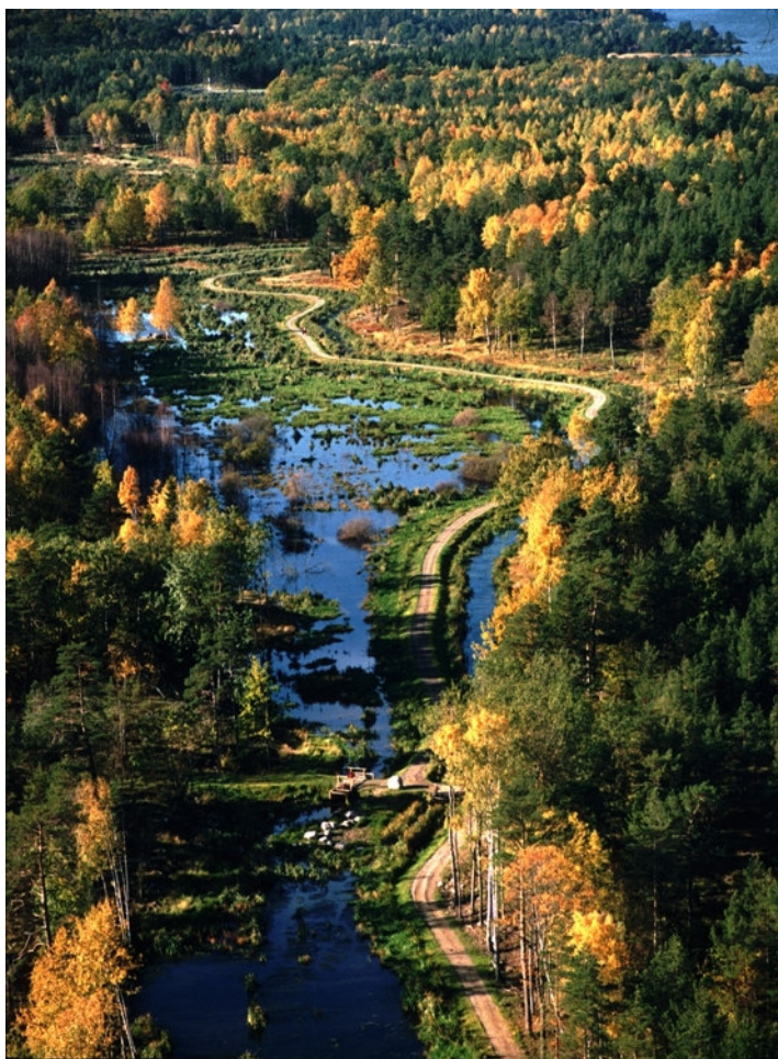
Figur 4. Oxelösunds våtmark. Bilden visar norra systemets andra damm (N2) samt en mindre del av den avslutande samlingsdammen (SN3) (Andersson m.fl., 2000).
