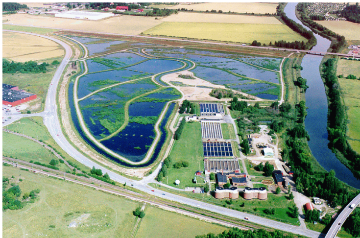
Figur 10. Eskilstuna våtmark och avloppsreningsverk. (Eskilstuna Energi & Miljö, 2005)
