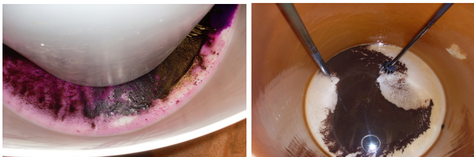
Figur 6.3.1 I den högra bilden ses kaliumpermanganat som inte ha lösts upp. Här är det utspolat ur doseringskärlet ut i invallningen. Den högra bilden visar botten av doseringskärlet, när det är tomt. I botten av kärlet är det brunsvarta fällningar.
