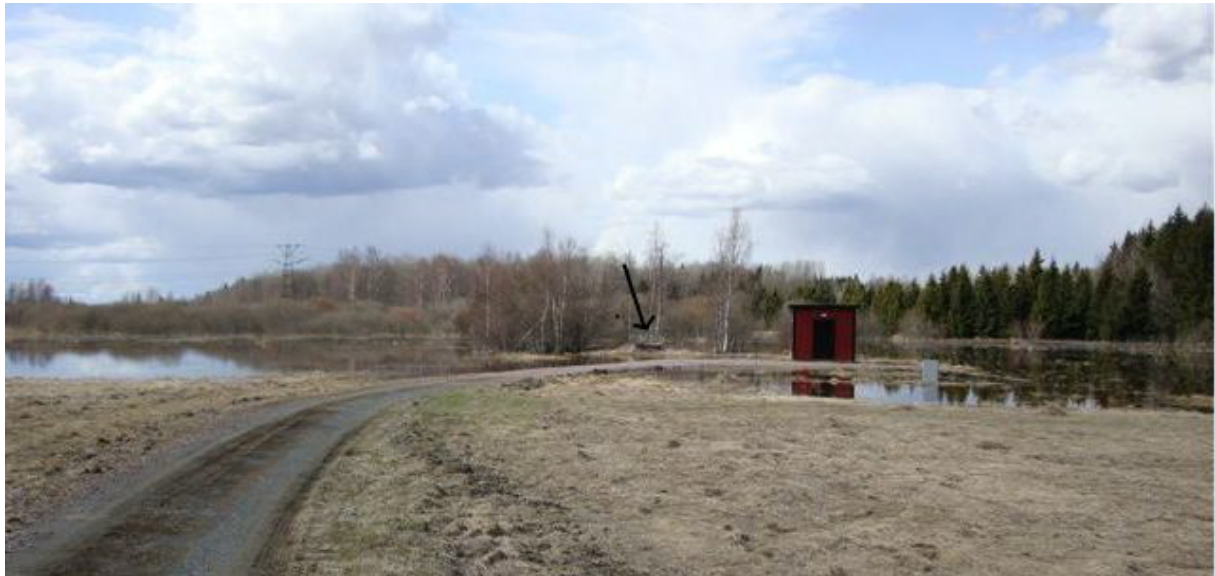
Figur 5.1.1 Marken kring pumphuset och brunnen vid Kyrkholmen är översvämmade. Pilen pekar på Kyrkholmsbrunnen och huset är pumphuset där de två pumparna står (Foto Håkan Rosenhoff).
