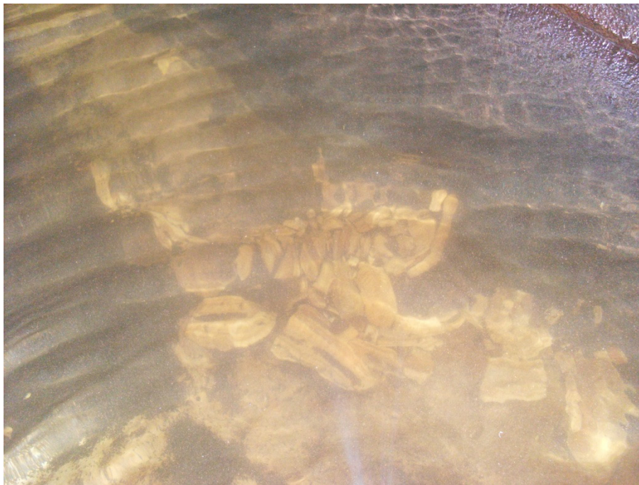
Figur 6.3.18 På lågreservoarens botten samlas alla fällningar som lossnat från stegpinnarna.
