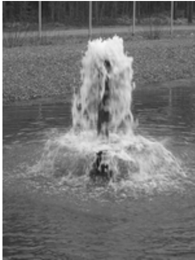
Figur 3. Syresättning av råvatten genom kaskadluftning. Foto från återinfiltrationsanläggning i Årboheden, Falun
