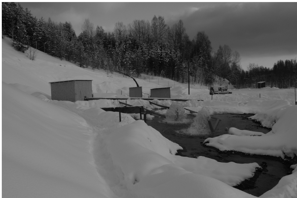
Figur 4. Brunnplatsen i Lennheden. Längst till vänster Br10, i mitten Br21 (som ligger längst in i planet) och till höger Br20. Foto Joel Dahné.
