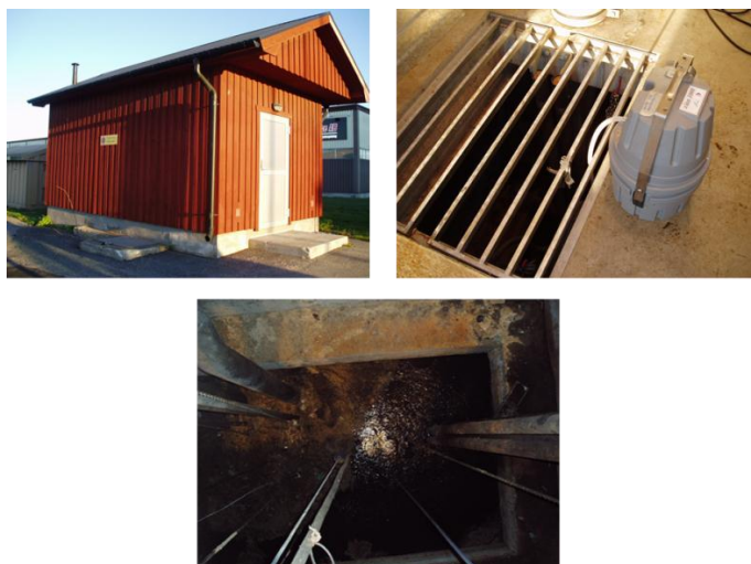
Figur 5: Högst upp, till vänster; Näringens pumphus. Högst upp, till höger; provtagaren, XIAN 1000. Längst ner, centrerad; det avloppsvatten som provtas.
