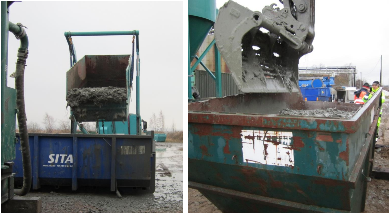
Figur 9. Homogenisering av muddermassor genom blandning med gallerskopa innan de pumpades till blandningsanläggningen. Bild från fältförsöket i Västerås till vänster och från Köping till höger.
