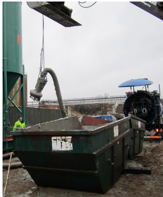
Figur 10. Till vänster, blandade massor pumpades ut i ena bassängen i Västerås. I bakgrunden ses den gröna blandningsstationen där de homogeniserade muddermassorna och bindemedlet blandades. Till höger, pumpen sänks ner i de homogeniserade muddermassorna för att pumpas upp till blandningsstationen.
