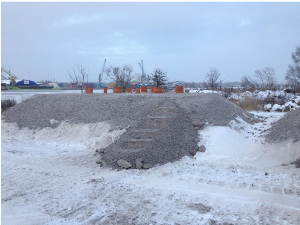
Figur 13. En av bassängerna i Västerås med 1 meter krossmaterial som överlast, detta ska motsvara 18 kPa.
