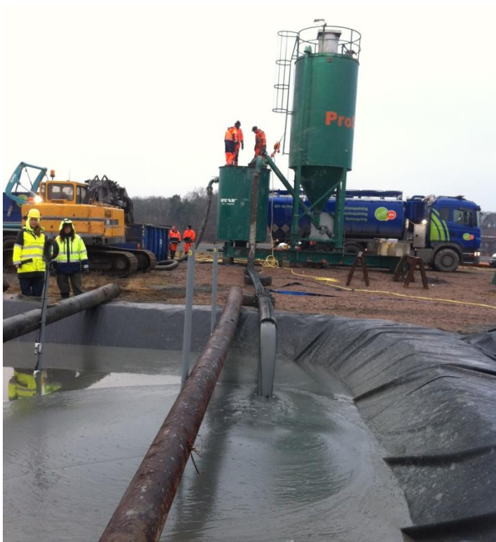
Figur 10. Till vänster, blandade massor pumpades ut i ena bassängen i Västerås. I bakgrunden ses den gröna blandningsstationen där de homogeniserade muddermassorna och bindemedlet blandades. Till höger, pumpen sänks ner i de homogeniserade muddermassorna för att pumpas upp till blandningsstationen.
