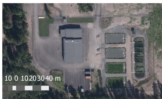
Figur 1. Flygfoto på Forsmarks avloppsreningsverk. I byggnaden finns SBR-bassängerna, till höger syns de fyra pulskärren och dammen. GSD-Ortofoto25 ©Lantmäteriet (2015)
