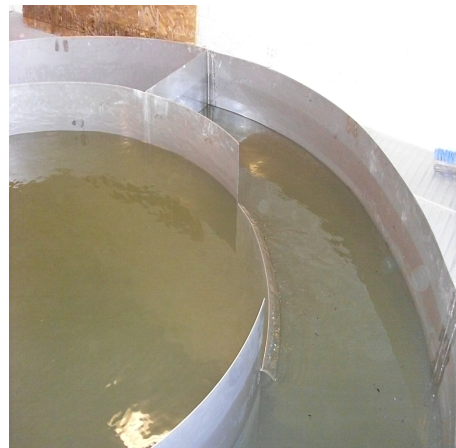
Figur 17 Bräddavlopp från tank till omgivande skibord. Vattnet rinner motsols, första skottet synligt uppe till vänster.
