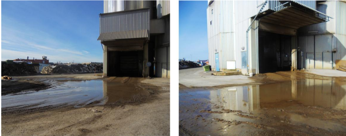
Figur 23 Askutmatningen utanför kraftvärmeverket (foto Linnea Henriksson).
