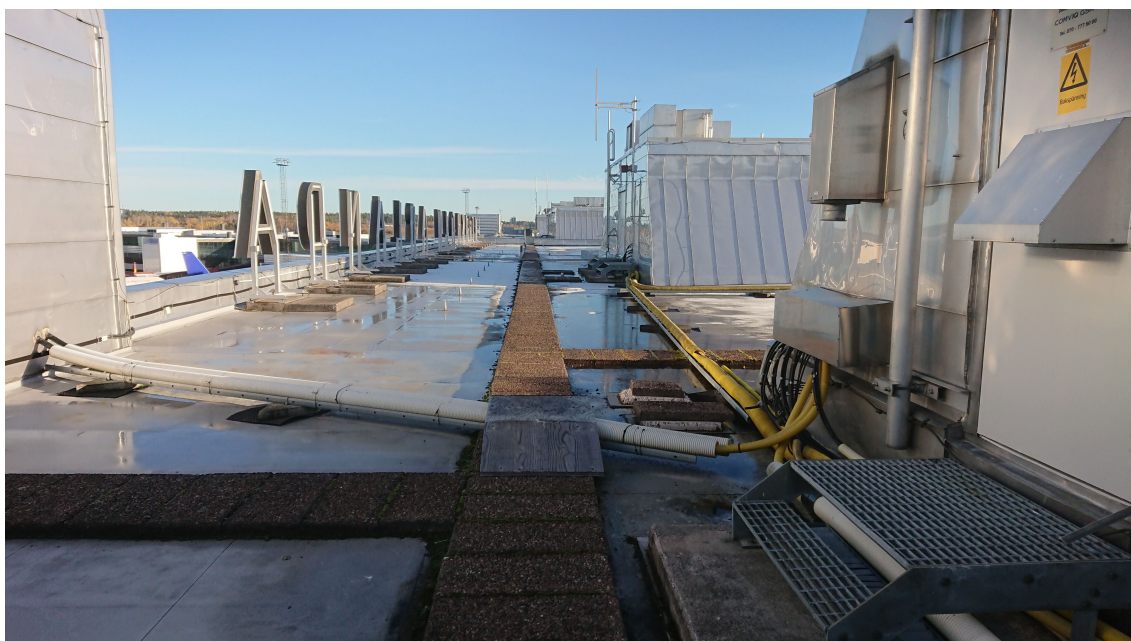
Figur 4: Generell bild av hur taket på terminalbyggnaderna med FPO-duk ser ut.
