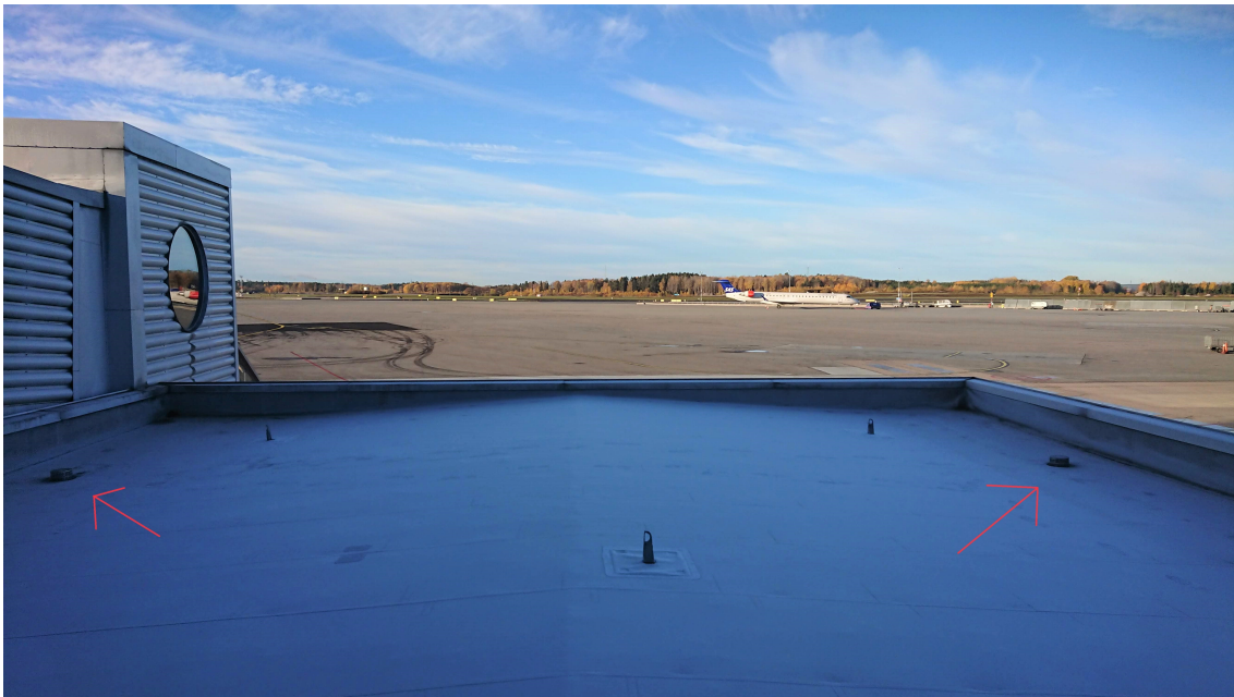
Figur 3: Bagagehall med PVC-duk. Två av de fyra brunnarna på taket är markerade med röda pilar.
