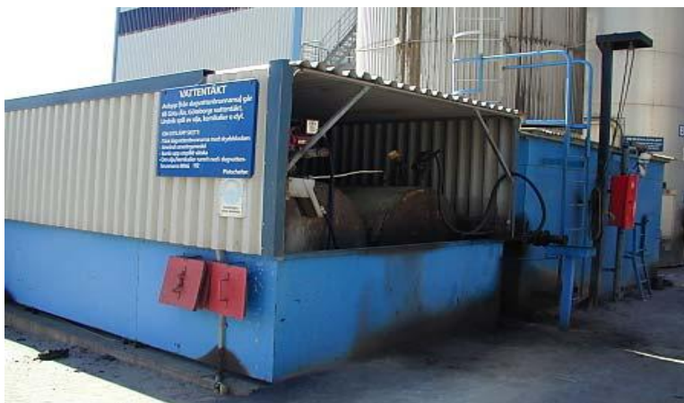
Figur 2 Exempel på invallning med regnskydd. Foto: Karin Gustavsson.
