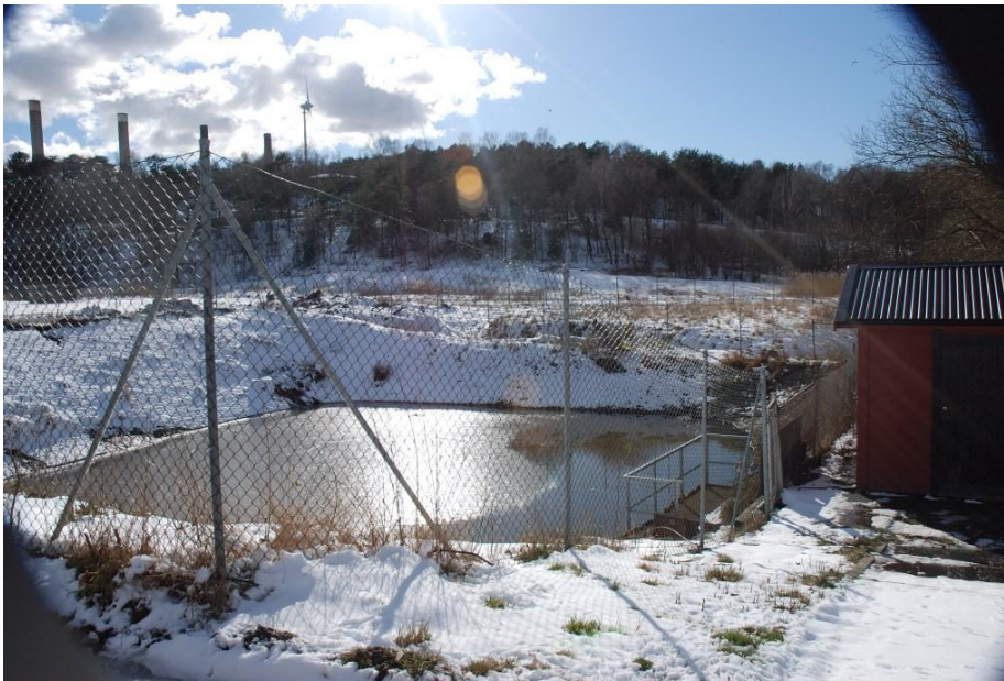
Figur 9 Utjämningsbassäng, Kläpp kretsloppsanläggning (Renova, 2008).
