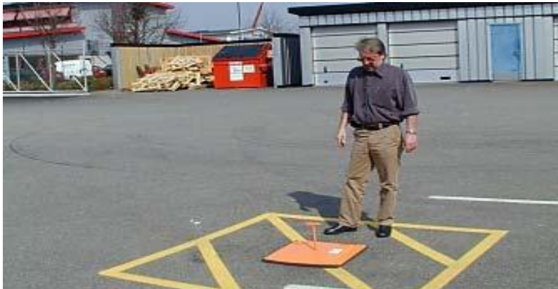
Figur 1 Exempel på markering av dagvattenbrunn samt placerat täcklock. Foto: Karin Gustafsson.
