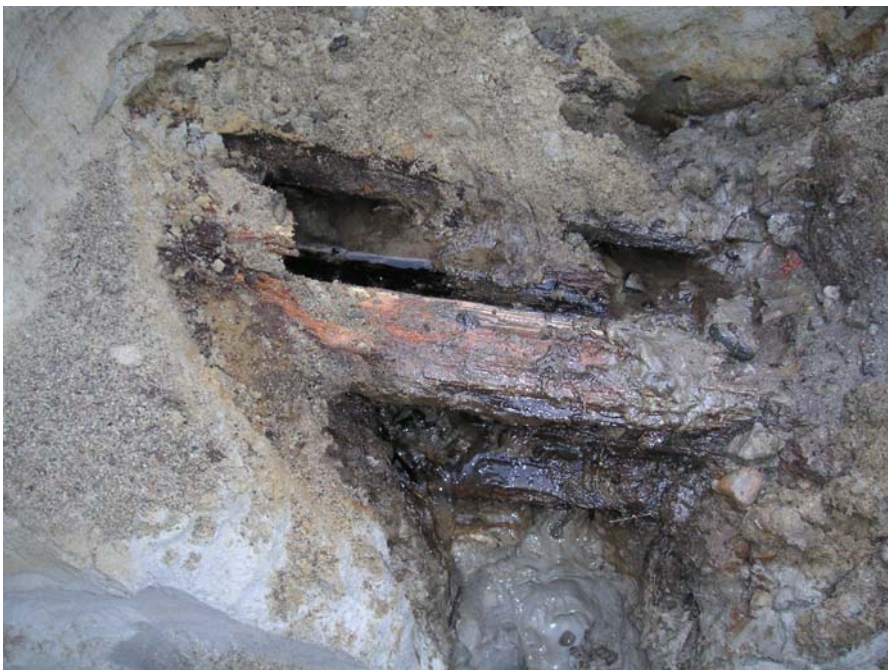
Fig. 2 En mindre trätub för dagvatten i området för björksulfatfabriken. Tuben är lagd direkt i det ursprungliga materialet som är finsand.
