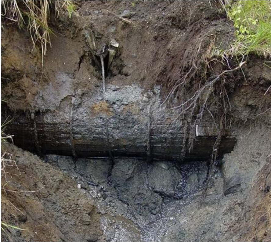
Fig. 1 Avloppstuben i cisternområdet. Tuben är lagd direkt på befintligt material och överlagrad med en sandig fyllning.
