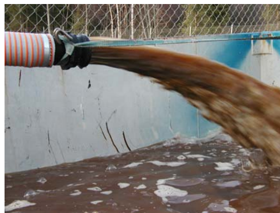
Figur 14. Den förorenade sanden pumpas till containrar.
