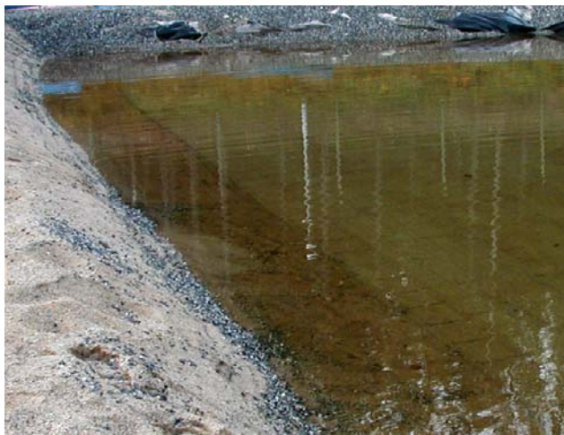
Figur 28. Långsamfilter 1, observera den bruna randen efter kanten som blir kvar efter rensning.
