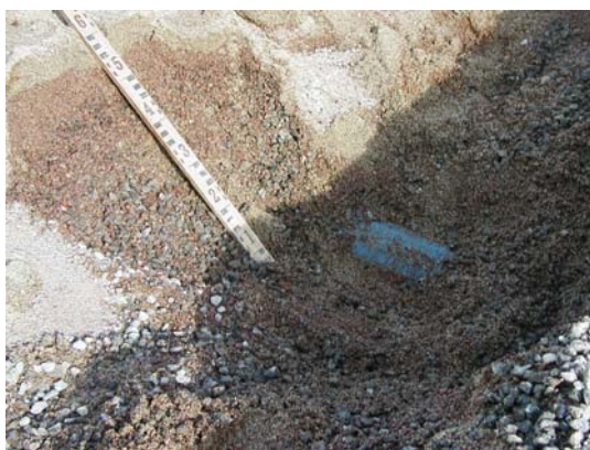
Figur 8. Urgrävning av filter 3 där dräneringsgrus med Raudrör ses i botten
