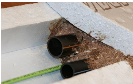
Figur 2. Isoleringsslåda vid reducerat djup (Skandinavisk kommunalteknik, medgivande 2014-03-18).
