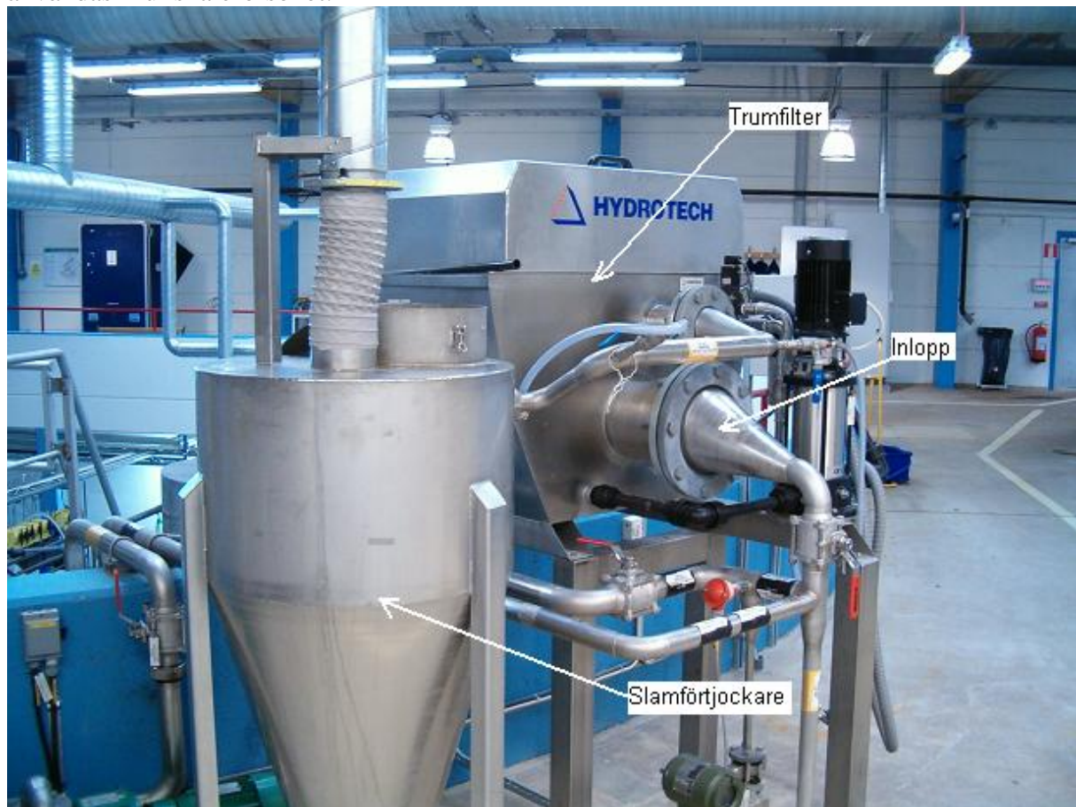
Figur 8. Trumfilter med slamförtjockare, linje 2, Sjöstadsverket.
