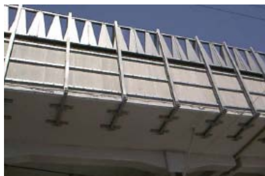
Figur 28. Bullerskärm med en spetsig topp för ökad sikt (Kanda m.fl. 2008)
