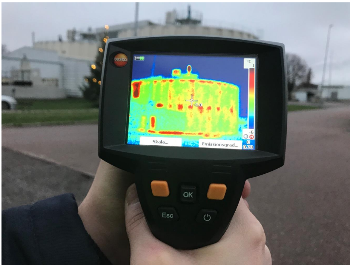
Figur 220. Bild från undersökning med värmekamera över rötkamrarna. Bilden är tagen av Henny Andersson, Uppsala Vatten och Avfall AB.
