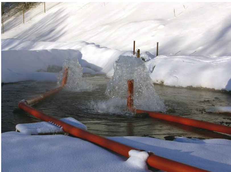
Figur 1 Uppumpat vatten luftas i fontäner och återinfiltreras, på så sätt syresätts vattnet och mangan kan fällas ut.
