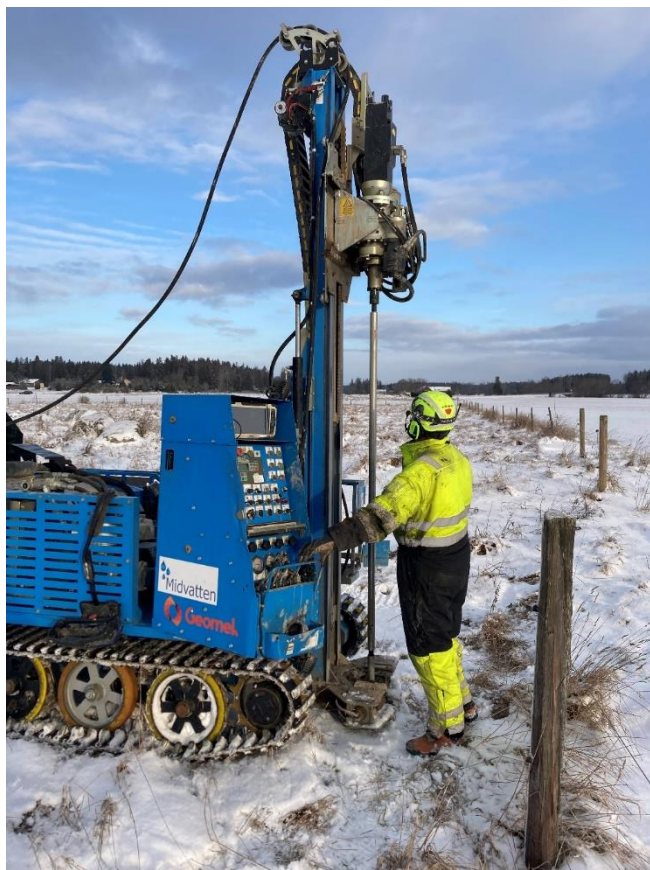
Figur A2: Den maskin som använts för sondering och rördrivning under projektet. På bilden pågår slagsondering
