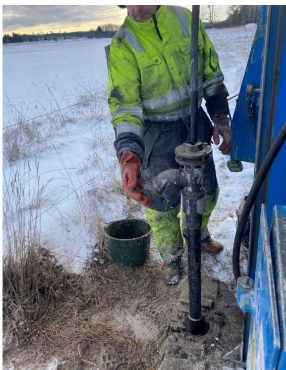
Figur A3: Till vänster: renblåsning av observationsrör under neddrivning. Till höger: exempel på uppblåst material för bedömning.
