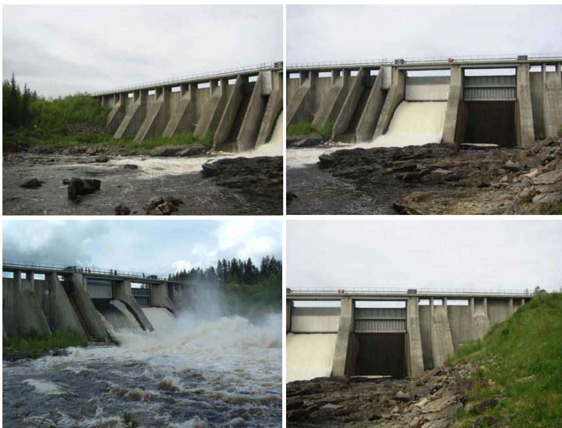
Figur 3 Skålanddammen (sett från nedströmssidan). Uppe till vänster visas typmonoliterna 15-10 (från vä-hö), uppe till höger visas utskoven (monolit 9-4 från vä-hö) och nere till höger visas typmonoliterna 3-1 (från vä-hö). Nere till vänster visas utskoven vid spill av vatten. Foto: Norconsult (2004).
