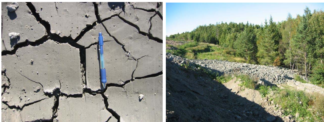
Figur 4 Sprickbildning (första bilden) och skred i samband med uppläggning vid Vedyxa.
