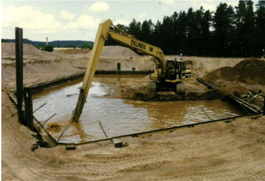
Figur 5. Schaktning med tätspont. Foto: Jan Andersson, 1997. Figur lånad från SWECO, med tillstånd.
