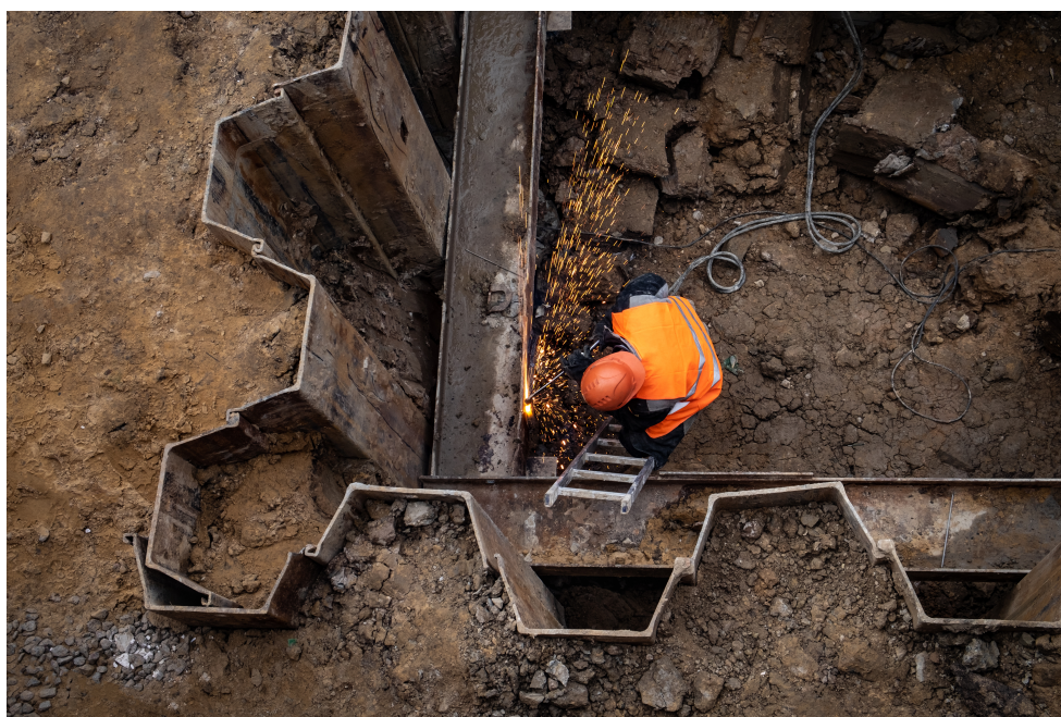
Figur 1: Stödkonstruktion med profilerad stålspont (Shutterstock 2023) (Licens-ID 1533693182)
