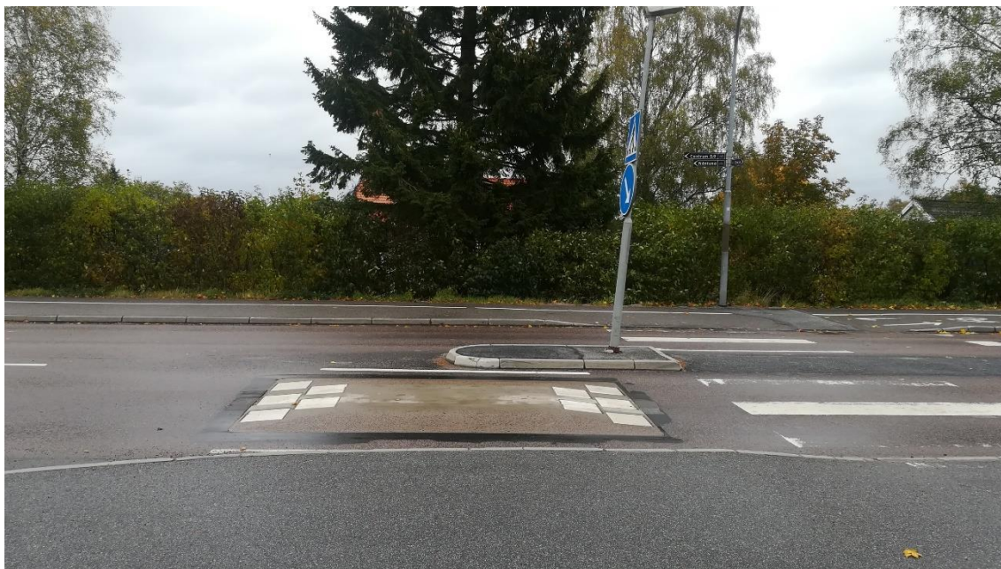
Figur 2. Busskudde placerad innan ett övergångsställe.
