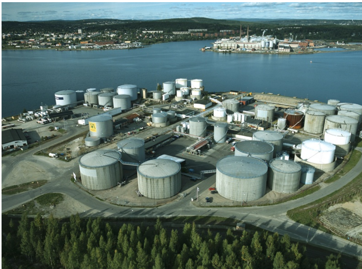
Figur 1 - Flygfoto från söder över Sundsvalls oljehamn. Vy mot norr (OK Q8 AB, 2003-09-22).
