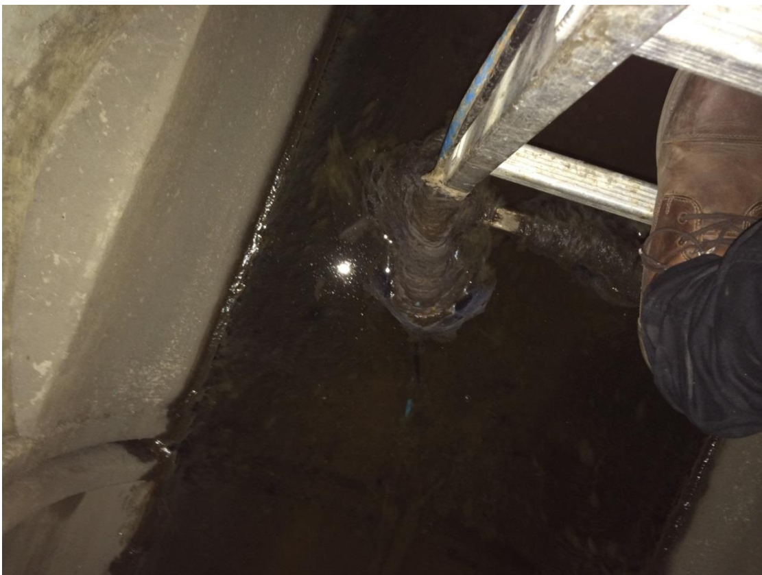
Figur B. 4 Grönbrunt slam i utloppsrör till uppsamlingsdamm
