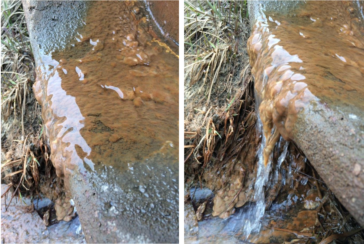
Figur B. 3 Brandgult slam vid utlopp från ledningssystem till uppsamlingsdamm.
