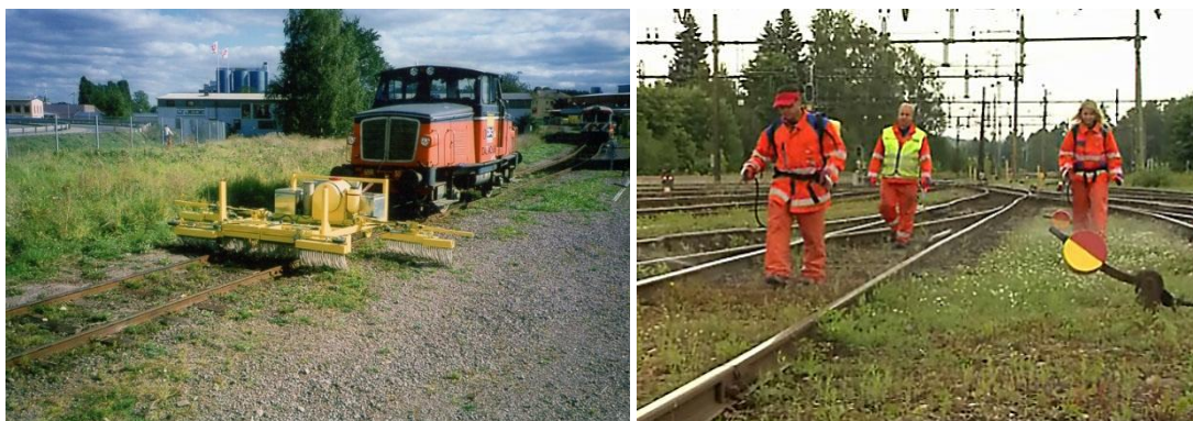
Figur 2-4. Bilden till vänster visar en hur metoden för avstrykning går till (Trafikverket, 2012d) Bilden till höger visar hur punktinsatser för kemisk bekämpning med ryggspruta går till (Trafikverket, 2012e).
