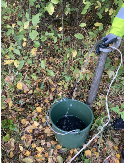
Figur 21. Murarhink för uppmätning av utpumpad vattenvolym under omsättning av grundvattenrören. Hinken rymmer 17 liter.
