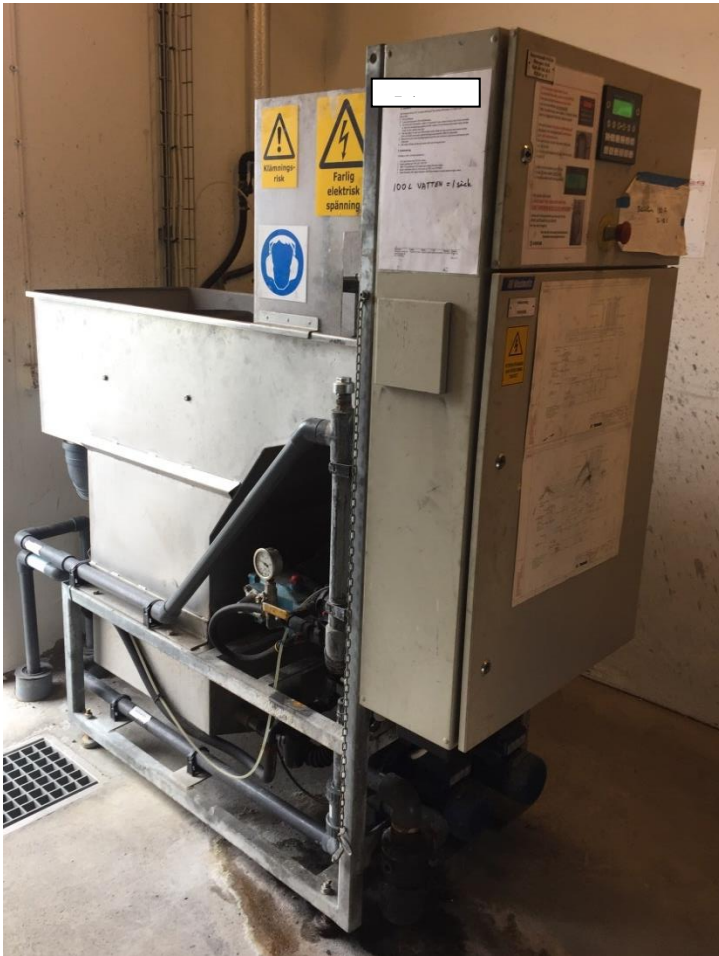
Figur 2. Maskinutrustning för elektroflockation. Foto: Ena Bahtic.
