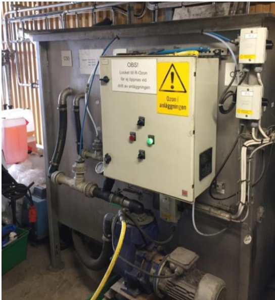
Figur 3. Ozonanläggning med dess inbyggda tre tankar inuti. Foto: Ena Bahtic.
