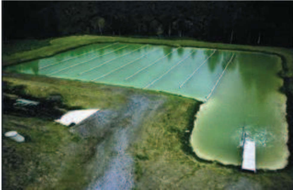
Figur 2. Fällningsdamm med väggar för att öka vattnets uppehållstid (Järven Ecotech, 2011).
