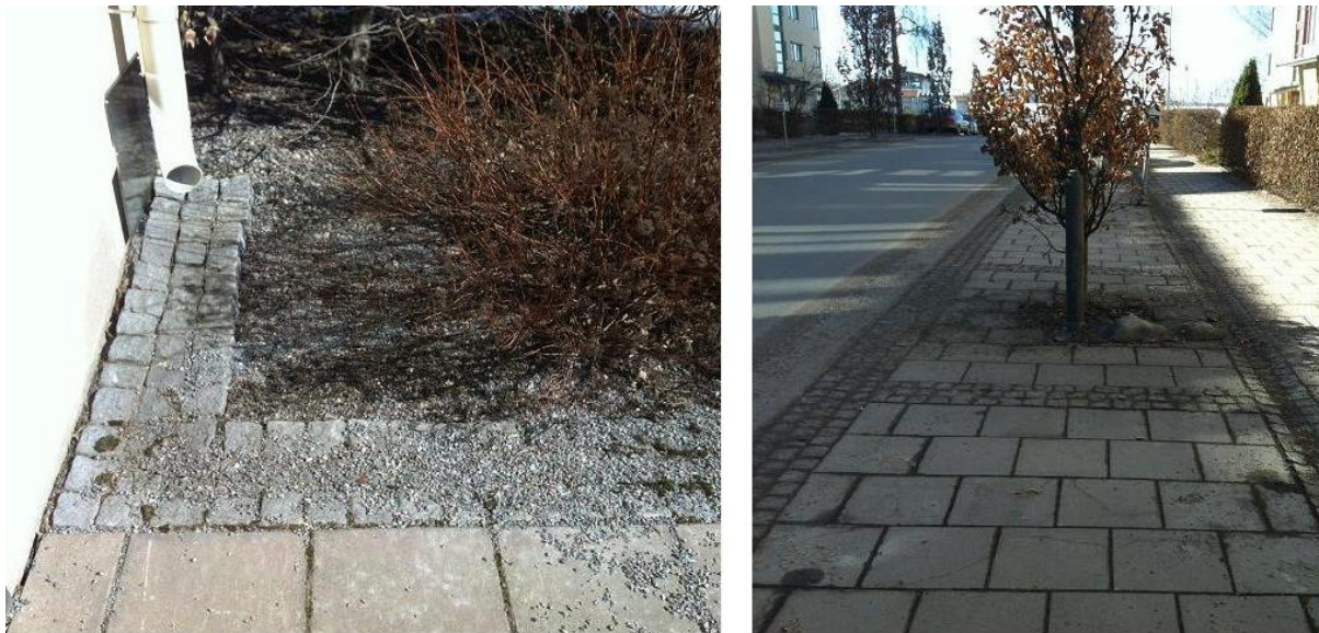
Figur 2. Till vänster: Stuprörsutkastare med stenlagd rännal. Till höger: Dagvattnet leds genom ett system i dagen till en infiltrationsyta (bild av Emma Matschoss-Falck).
