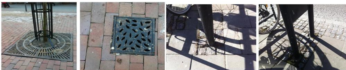
Figur 18. Till vänster och mitten/vänster: Arrangemanget för ett planterat träd längs Smedjegatan samt en avloppsbrunn på samma gata. Till höger och mitten/höger: Arrangemang runt lyktstolpar och skyltar längs Vasagatan (bild av Emma Matschoss-Falck, 2013).
