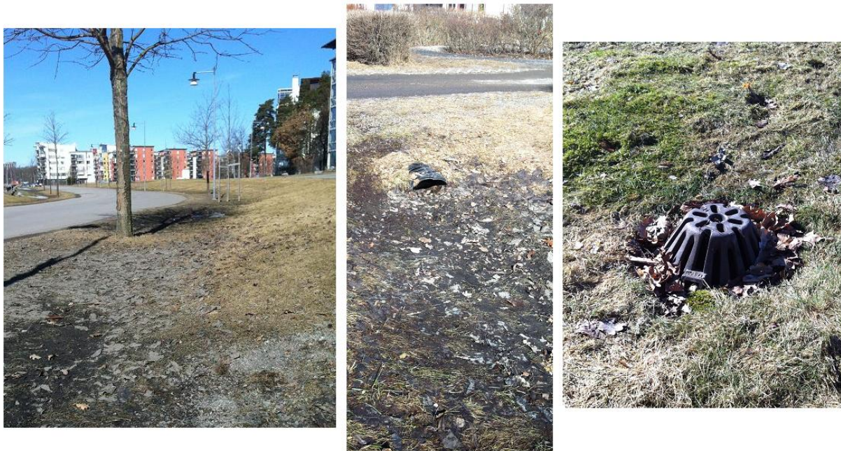
Figur 3. Ett långsträckt svackdike på Öster Mälarstrand i Västerås. Vattnet leds under vägar med smalt dimensionerade rör. Svackdiket är också försett med en upphöjd brunn i en lågpunkt (bild av Emma Matschoss-Falck).
