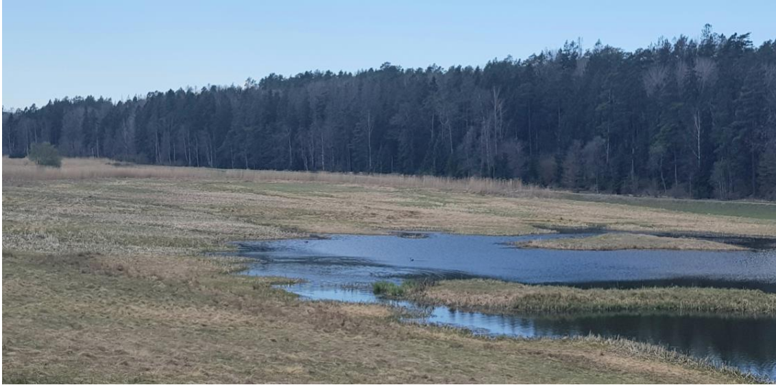
Figur 4. Översilningsytan ner till Skålpusedammen i Alhagen våtmark. Den flacka gräsytan ger spridning och syresättning till vattnet.
