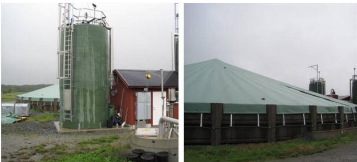
Figur 8. Karby våtkomposteringsanläggning. Till vänster syns en av de två reaktorerna intill styrhuset. Till höger ses efterlagret med de två reaktorerna skymtandes i bakgrunden. Foto: Emelie Ljung
