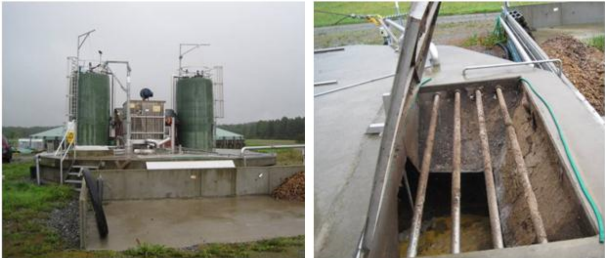
Figur 7. Karby våtkomposteringsanläggning. Till vänster ses hela anläggningen och i förgrunden skymtar slangen som används vid tillsats av pumpbart material. Till höger syns luckan på förlagret dit fast råmaterial kan tillsättas. Foto: Emelie Ljung
