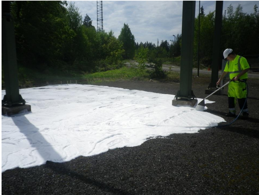
Figur 8. Utläggningen av Spuma i en av Svenska Kraftnäts anläggningar.
