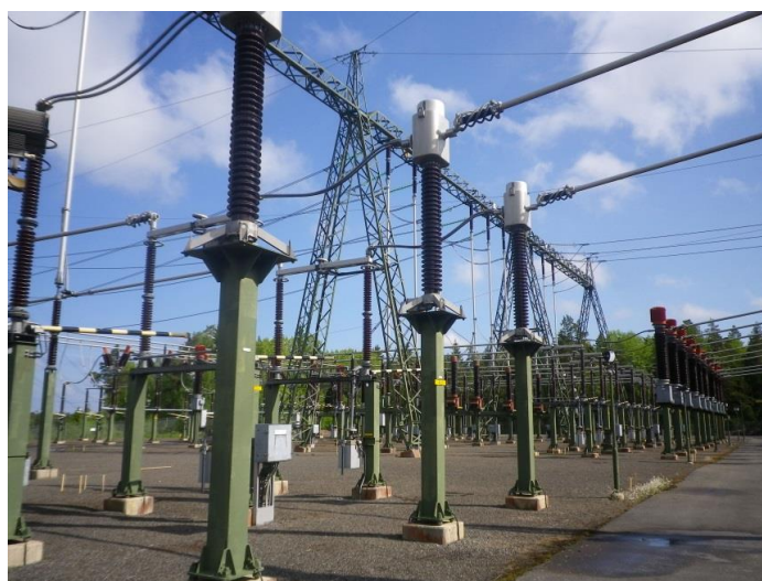
Figur 1. Inom området finns flera stativ och på 3,5 m höjd finns högspänningsledningarna. Stolpar och kraftledningarna begränsar framkomligheten.
