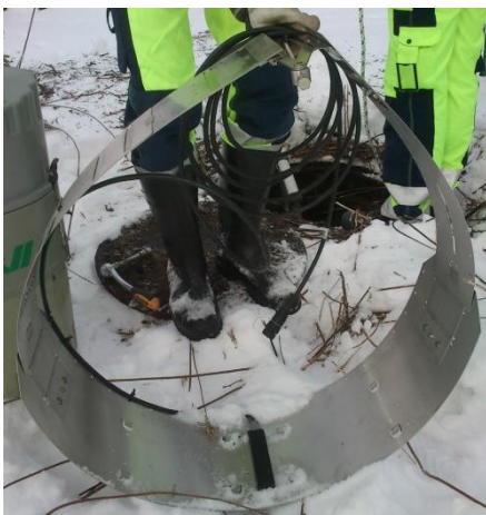
Figur 9. Flödesmätaren är den svarta dosan som sitter fast i botten på ringen som spänns upp i röret där vattenflödet ska mätas. Till vänster i bilden syns ISCO provtagaren (författarens bild).
