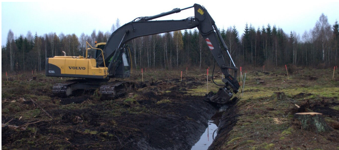
Figur 1: Dikesrensning för att återställa dikesbotten. Foto : Eva Ring.
