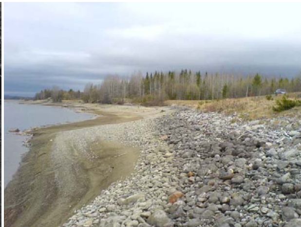
Figur 13. Erosionskydd uppströmslänt dammenhet 3.
