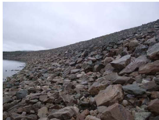
Figur 4. Oordnat erosionskydd, Grundsjädammen
