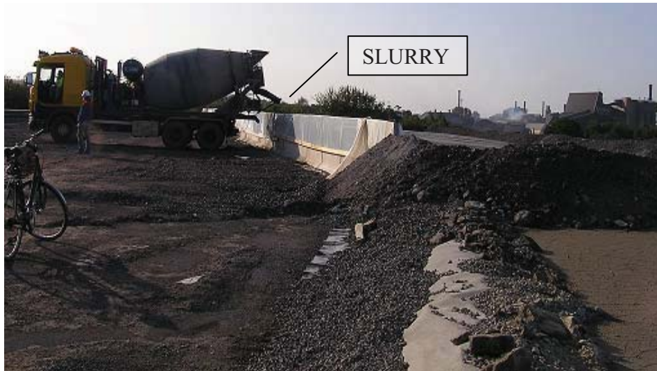
Figur 3 Deponering av behandlat ferrokromstoft från betongblandarbilen i celler ovanpå deponin. Vargön Alloys AB industribyggnad ses i bakgrunden till höger. Deponering sker på bilden i cell 2, bakom betongblandarbilen är cell 1 belägen. Till höger i förgrunden ses provcellen i vilken torkad slurry syns.
